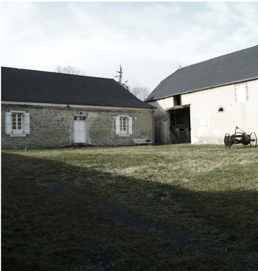
FAÇADE ANCIENNE FAIBLEMENT PERCÉE
