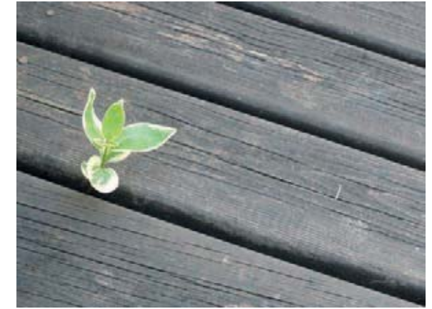
lames de bois en prolongement de la terrasse existante
