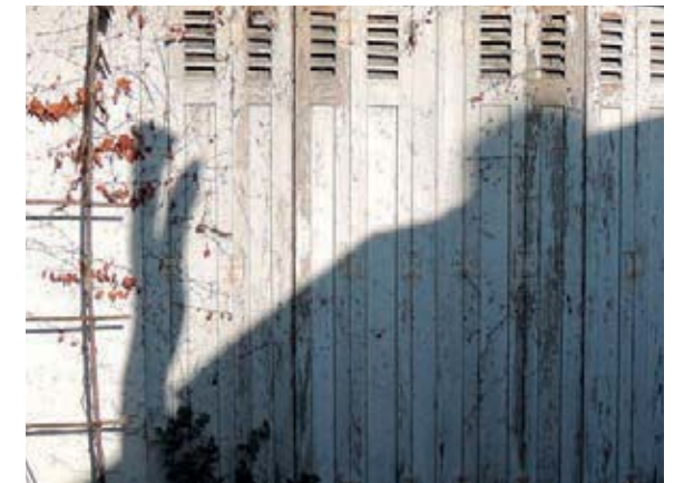
façade persiennes, récupération des volets existants
